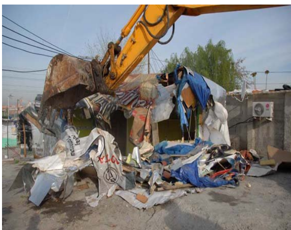
Fig. 1. Locuințe informale demolate în Santa Catalina, Madrid, 2010
